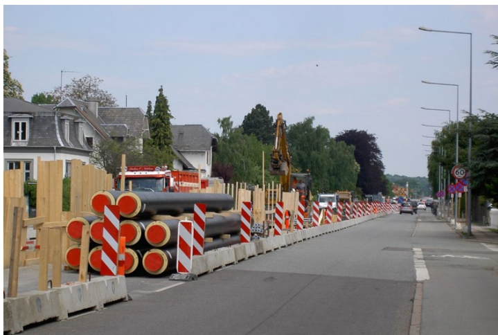
Fjernvarmearbejde på Bernstorffsvej som en del af Fase 3
